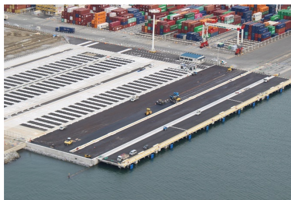
岸壁（-15m）岸壁築造（舗装）
