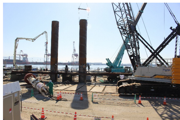
岸壁（-15m）岸壁築造（鋼管杭打設）
