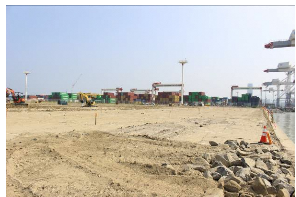
市3の2の2工区 地盤改良（二次覆土撤去）
