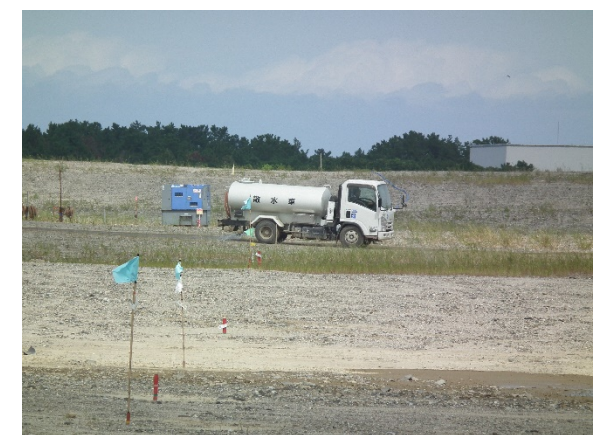
工事区域内の散水
