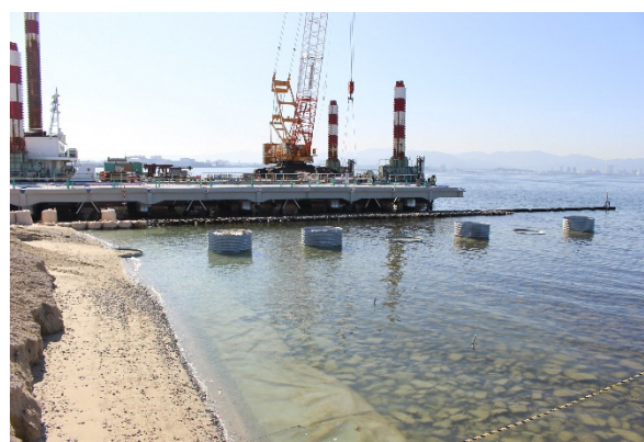
岸壁（-15m）岸壁築造（床版製作・設置等）
