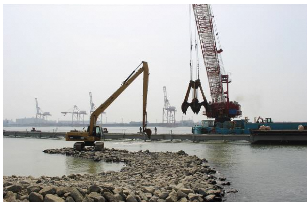
岸壁（-15m）岸壁築造（裏込・裏埋雑石）
