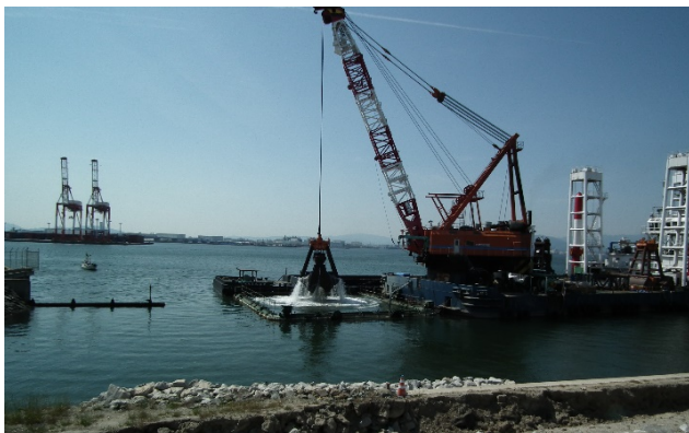
岸壁（-15m）岸壁築造（床掘）
