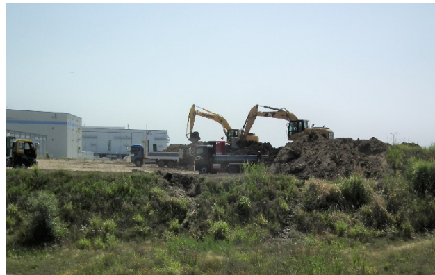
市5の3工区 地盤改良（二次覆土撤去）
