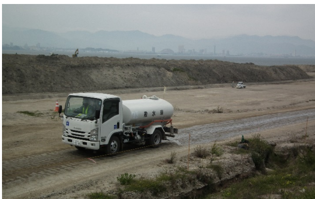
工事区域内の散水
