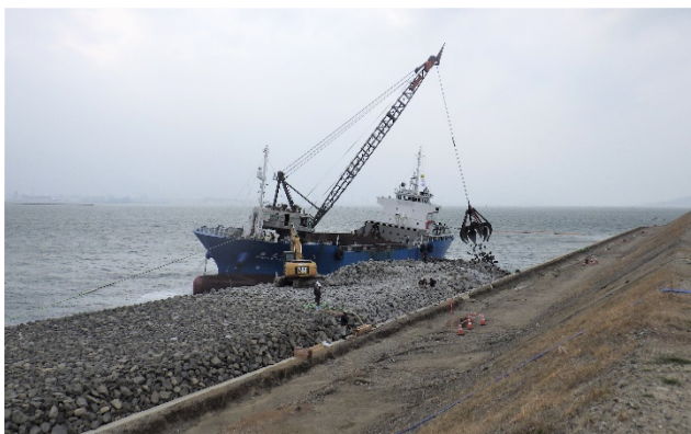
岸壁（-15m）岸壁築造（裏込・裏埋雑石）
