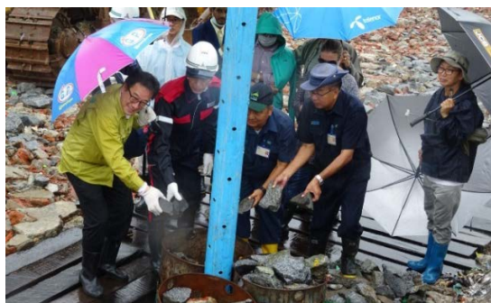
ガス抜き管の設置のデモンストレーション
