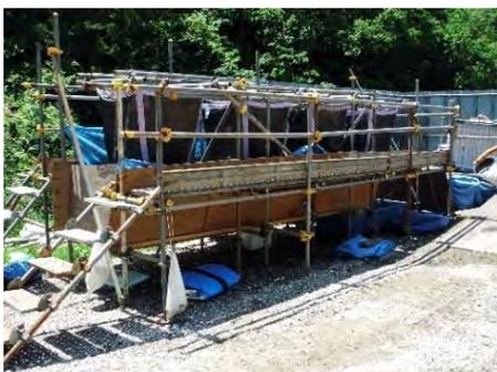
↑ 福島県除染作業時に発生する汚染水処理
