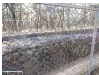
フェンス現況
