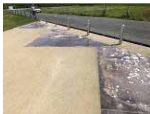
図5-18 舗装表示(吉武高木遺跡)
