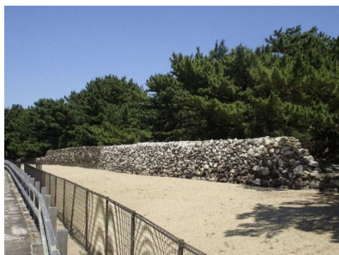
図 3-7 生の松原地区復元整備
