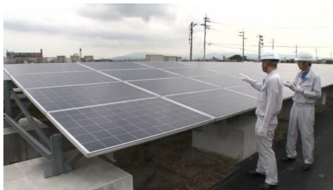
図表 57 太陽電池モジュールの外観検査
