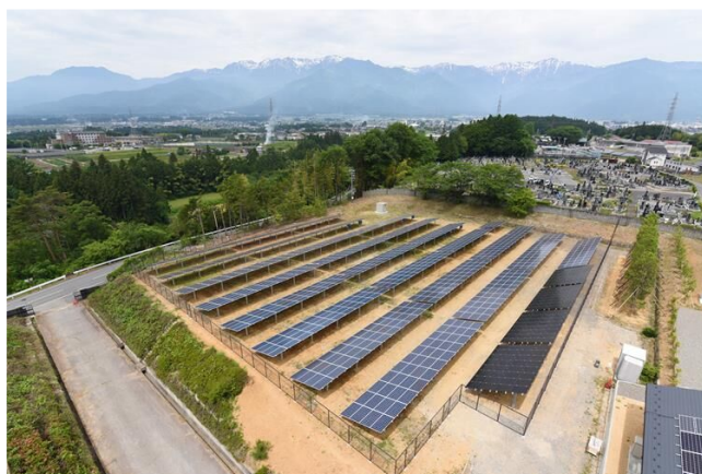
図表 58 リユース品を使用した発電所
