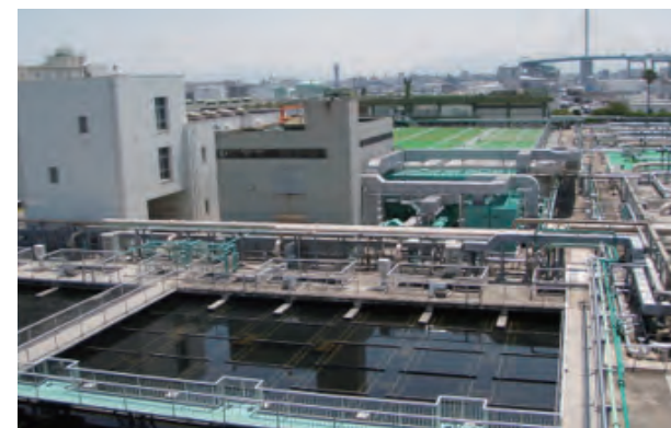
▲水処理センター
