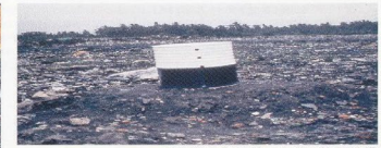
廃ドラム缶を使ったガス抜き設備
