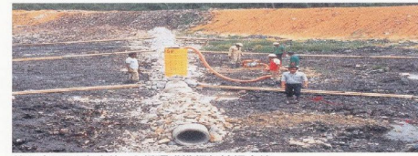
竹や廃ドラム缶を使った循環式準好気性埋立地
