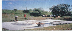
多目的酸化池での曝気 (1996年)
