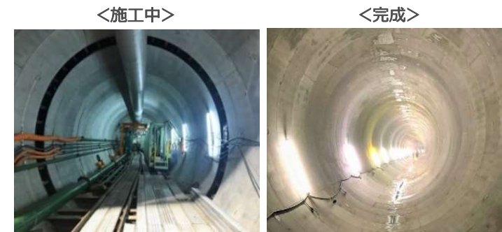
雨水管整備イメージ（中部2号幹線 内径5.00m）
