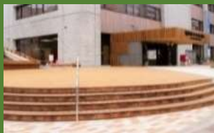
(R3年度事例) 区役所の玄関前広場に木製 デッキを整備（中央区役所）
