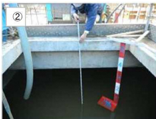
水張り試験（湛水試験）の実施状況
