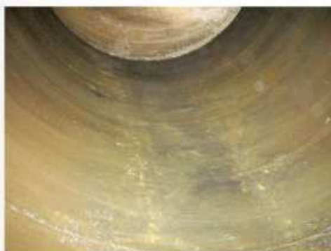
燃料タンク内部清掃作業後
