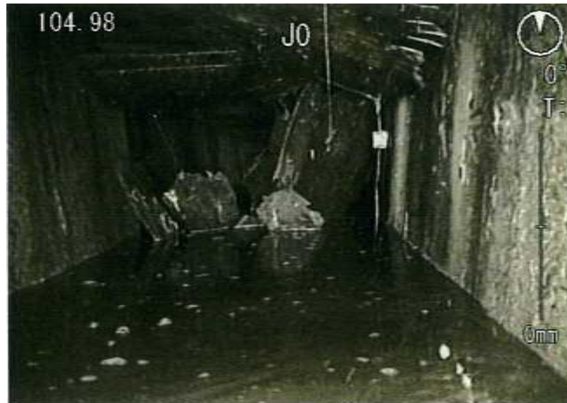
管路の封鎖状況 (松山市提供)
