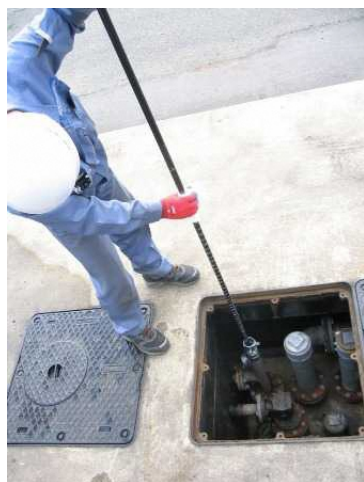
③タンク内より引き上げ
