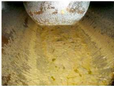
燃料タンク内部清掃作業前
