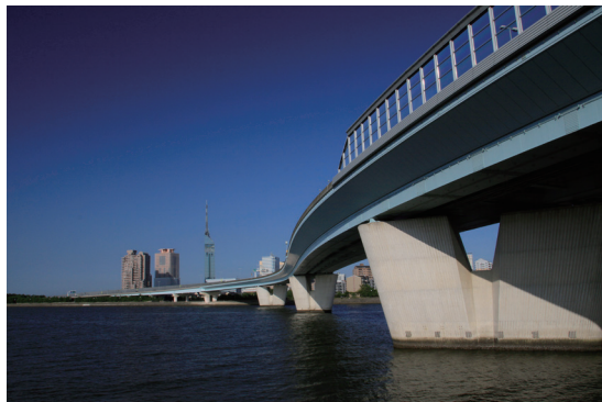
室見川にかかる都市高速道路
