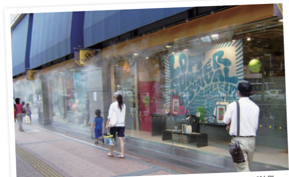
周囲の温度を下げてくれるドライフォグは、粒子が細かくぬれないのが特徴。店先に打ち水のような効果をもたらしてくれます。
