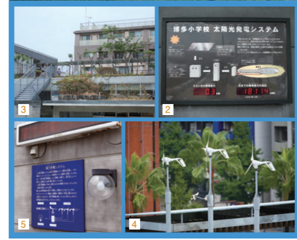
1 2 太陽光発電が設置された透明の屋根は、景観的にもとてもユニーク。傍らに設置された電光掲示板には発電電力が示されています。 3 緑であふれる校舎をめざし、ベランダなどは緑化が進んでいます。 4 5 風力発電のための小さな風車も設置。うまく電力を得ることができれば、プール横の小さな照明に灯りがつく仕組みです。
