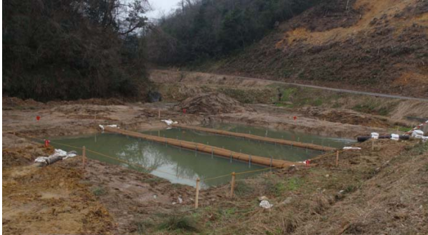
<仮設沈砂池の設置>
