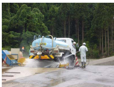
<工事用車両のタイヤ洗浄>
