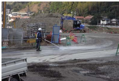
<工事施工ヤードへの散水>
