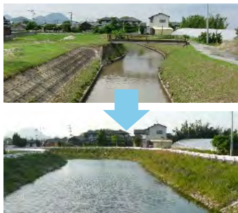
河川の改修（周船寺川の拡幅）
