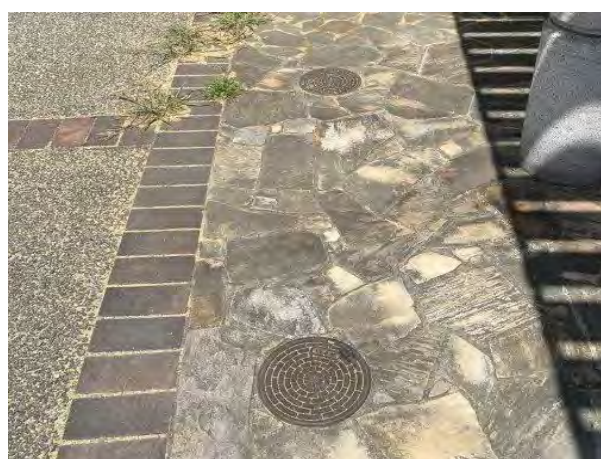
マンホールトイレ（大浜公園）
