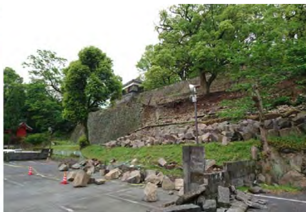
図：熊本地震による熊本城の石垣の崩壊状況
