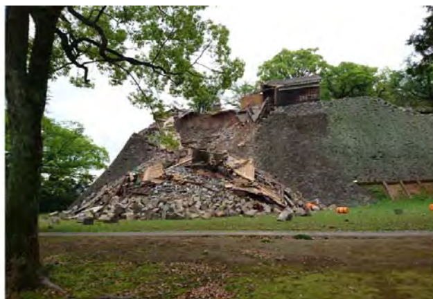
図：熊本地震による熊本城の石垣の崩壊状況
