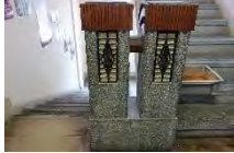
窓下面台クリンカータイル
