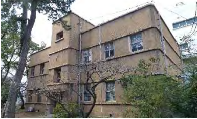
外壁上段 ダブルスクラッチタイル
