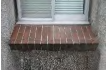
窓下面台クリンカータイル
