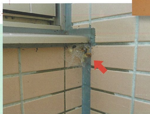
石段・ 窓の出し張り
