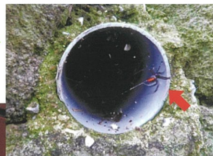
擁壁などの 水抜き穴
