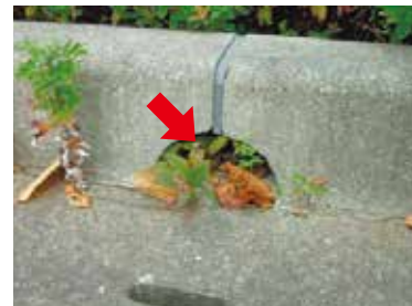
擁壁などの 水抜き穴
