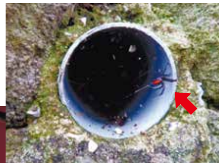
擁壁などの 水抜き穴
