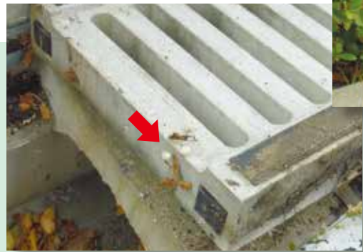
雨水側溝の コンクリート ふた
