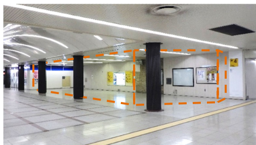
博多駅筑紫口リニューアル事業 (店舗区画創出)
