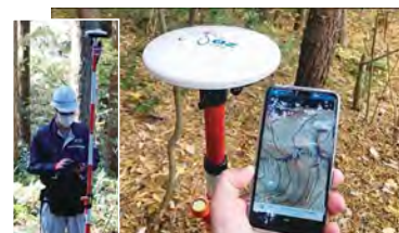
境界明確化の作業風景
