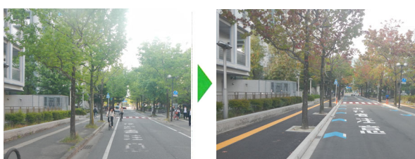
■写真9 歩道のバリアフリー化 (マウントアップの改善、誘導ブロック設置)
