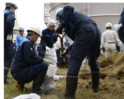
土のう製作の様子
