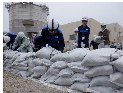
土のう積みの様子
