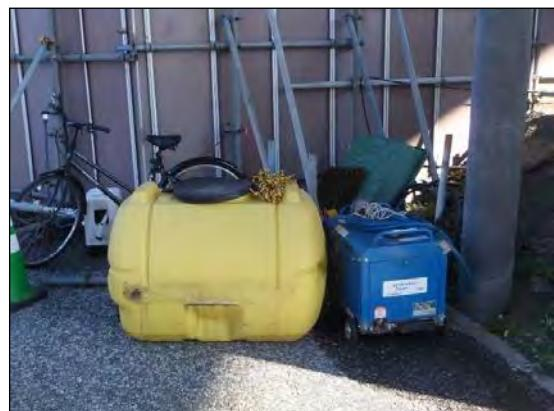
写真①-6 工事用車両のタイヤ洗浄設備
