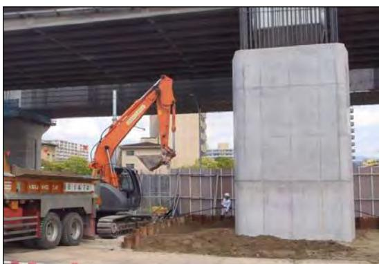
写真①-7 発生土での埋戻し
