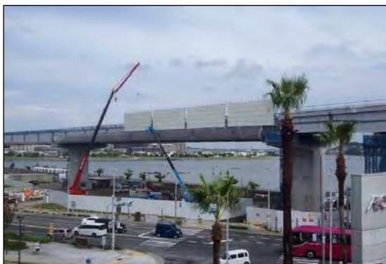
写真②-3 防音用落下防護棚の設置
