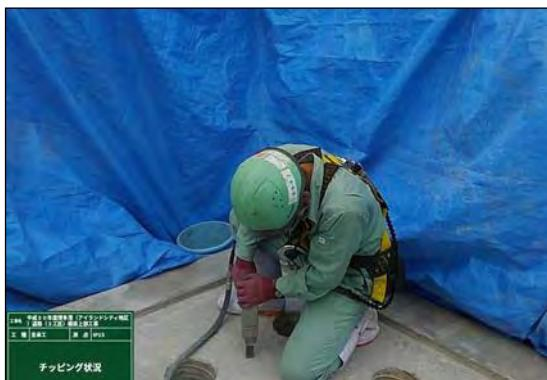
写真③-5 脚座チッピング作業時の
