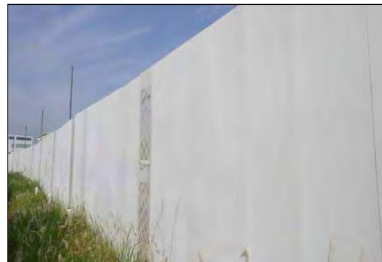
写真③-6 防音パネルの設置
