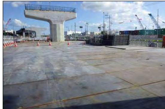
写真⑤-6 敷鉄板の設置による粉じん対策
