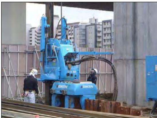
写真①-5 低振動工法の採用
