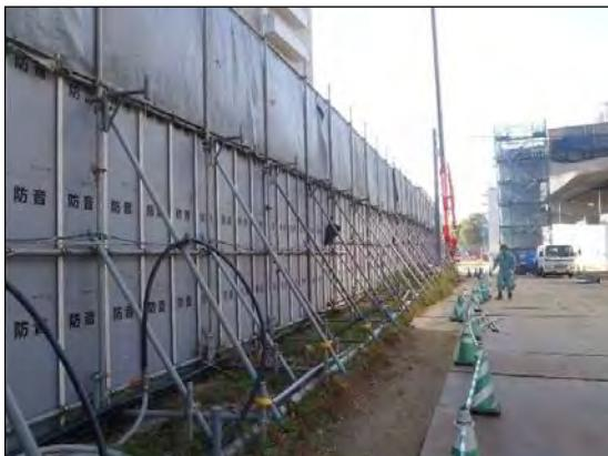
写真①-3 防音パネルの設置
