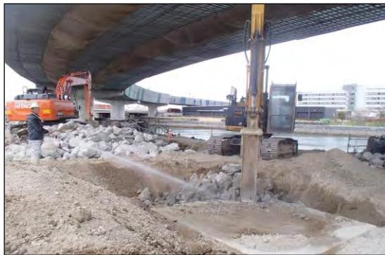
写真④-1 施工ヤードへの散水
