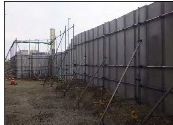
写真③-6 防音パネルの設置
