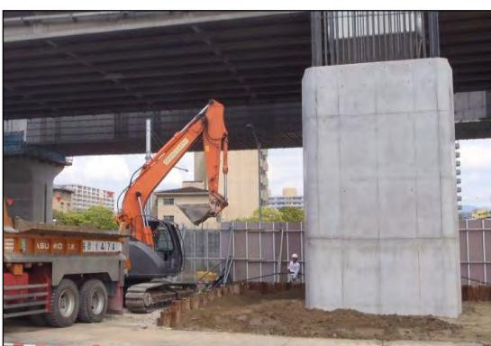
写真①-7 発生土での埋戻し
