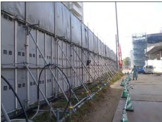
写真①-3 防音パネルの設置
