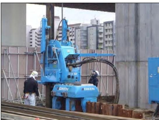
写真①-5 低振動工法の採用
