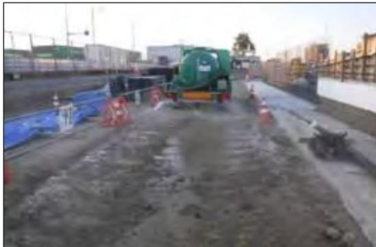
写真⑤-1 施工ヤードへの散水状況
