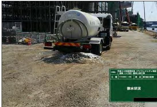
写真③-1 施工ヤードへの散水状況
