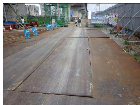
写真③-8 敷鉄板の設置による粉じん対策
