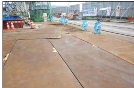
写真④-6 敷鉄板の設置による粉じん対策
