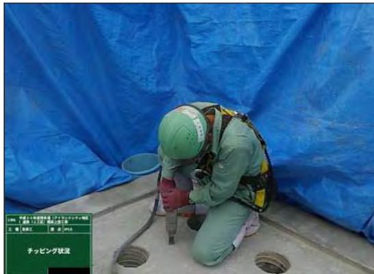
写真③-5 遮座チッピング作業時の
