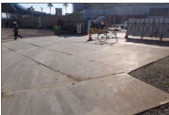
写真②-7 敷鉄板の設置による粉じん対策
