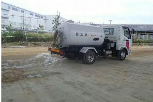
写真③-1 施工ヤードの散水状況
