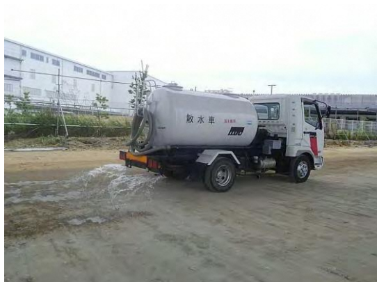
写真③-1 施工ヤードの散水状況
