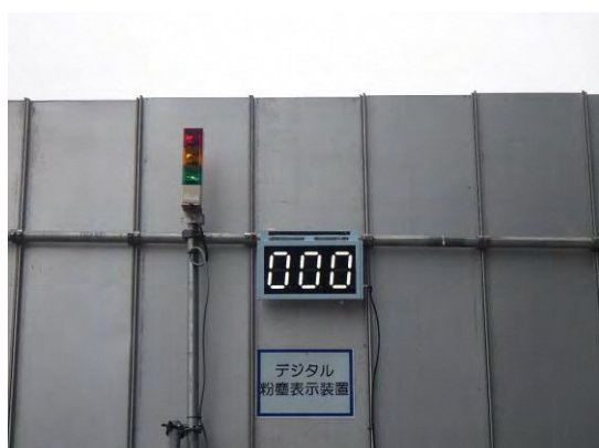
写真③-3 粉じん計による測定状況
