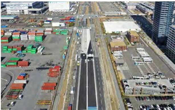
工事進捗状況写真（令和3年2月）
