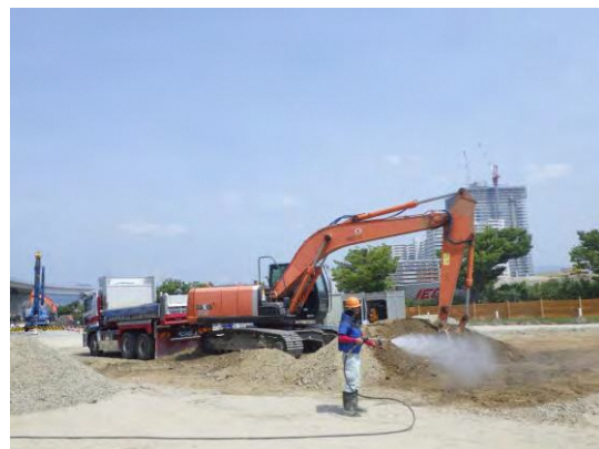
写真③-2 散水状況
