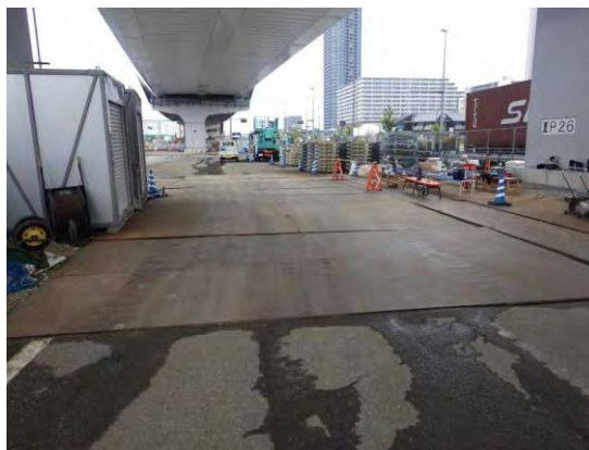
写真⑤-5 敷鉄板の設置による粉じん対策
