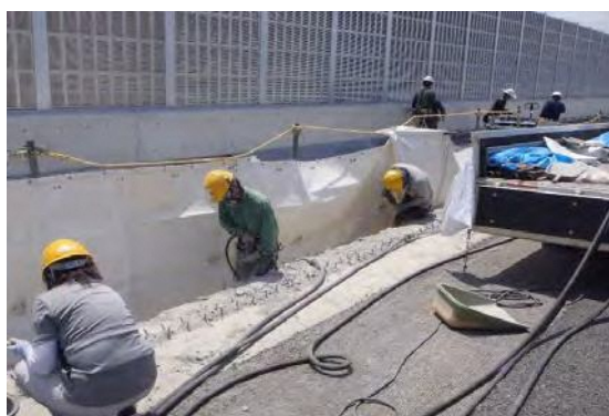
写真①-3 防音シートの設置による遮音対策
