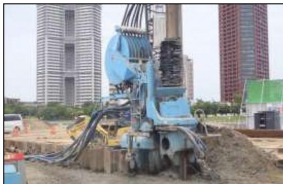
写真③-5 低振動工法の採用
