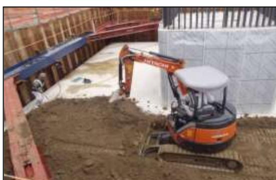
写真②-7 発生土による埋戻し
