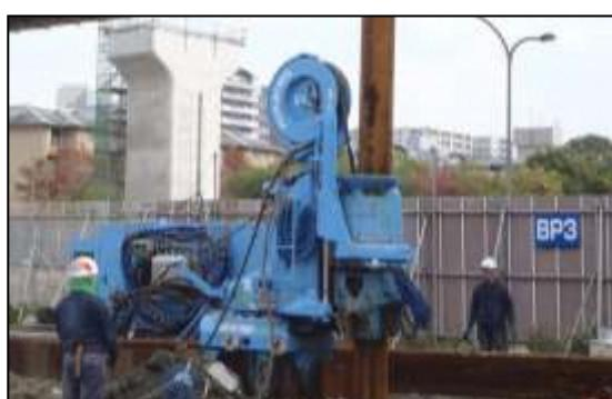
写真②-5 低振動工法の採用
