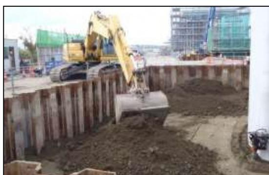
写真③-7 発生土による埋戻し
