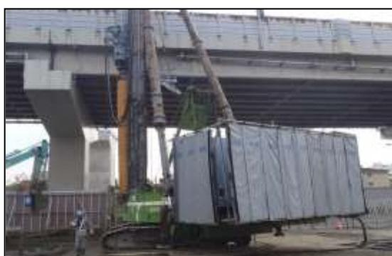
写真①-5 低振動工法の採用
