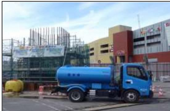
写真①-1 施工ヤードへの散水設備
