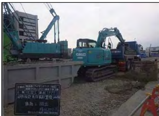
写真⑤-7 発生土の積込状況
