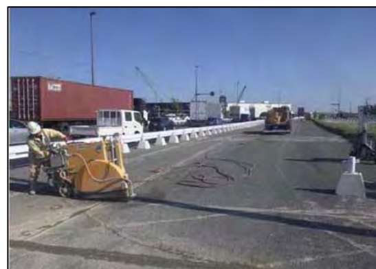
写真⑤-8 建設汚泥の回収状況
