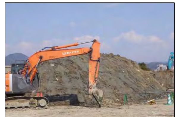
写真②-8 発生土の仮置き
