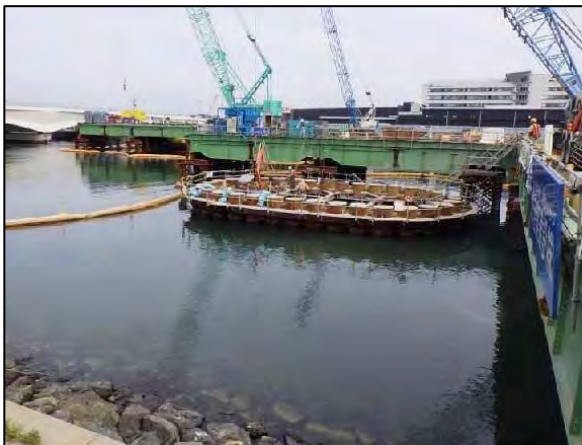
写真④-5 汚泥防止膜の展張状況
