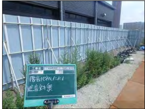
写真④-2 防音パネル等の遮音対策
