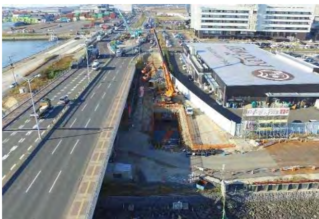
工事進捗状況写真
