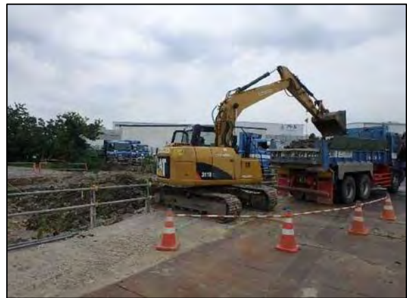
写真④-6 建設汚泥の積込状況
