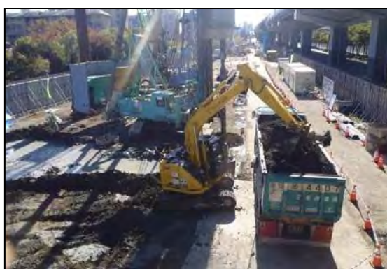
写真①-8 建設汚泥の積込状況
