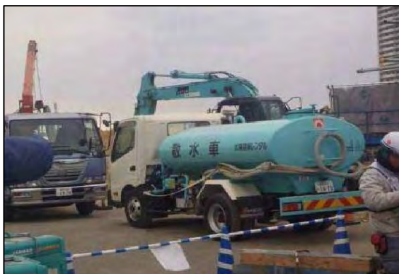
写真③-1 施工ヤードへの散水設備
