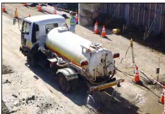
写真①-1 施工ヤードへの散水状況
