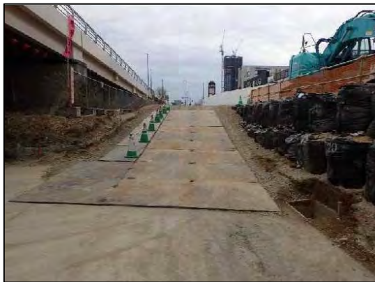
写真⑤-1 敷鉄板の敷設状況
