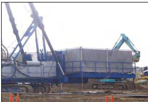
写真③-3 発電機の防音シート
