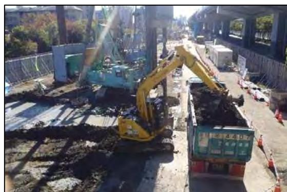
写真①-8 建設汚泥の積込状況
