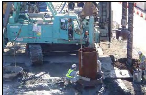
写真①-6 低振動工法
