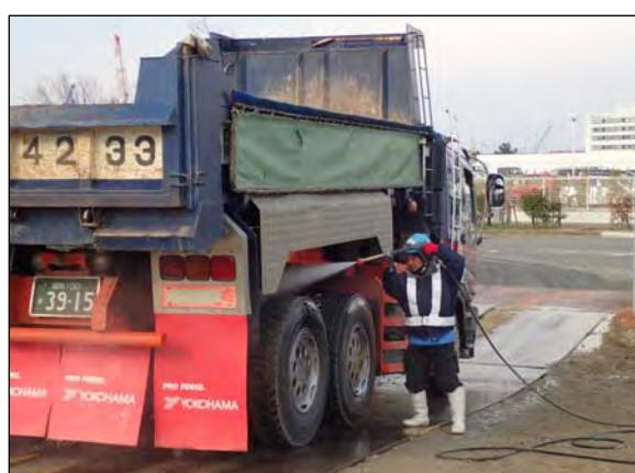
写真①-6 工事用車両のタイヤ洗浄
