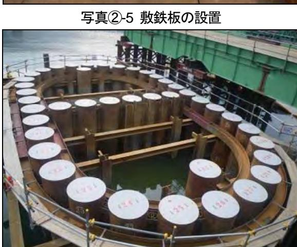
写真②-7 鋼管矢板による橋脚下部の囲い込み
