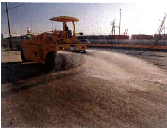
写真③-1 施工ヤードへの散水
