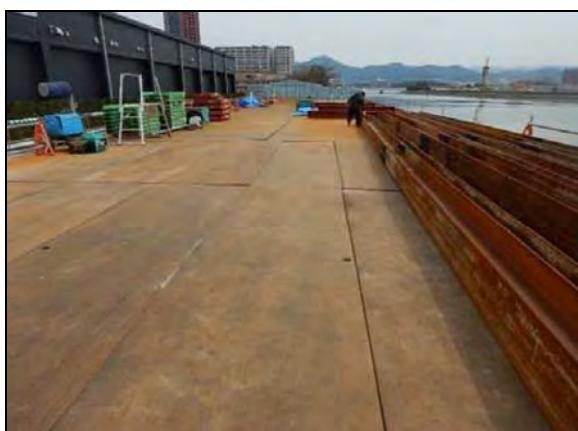
写真②-5 敷鉄板の設置
