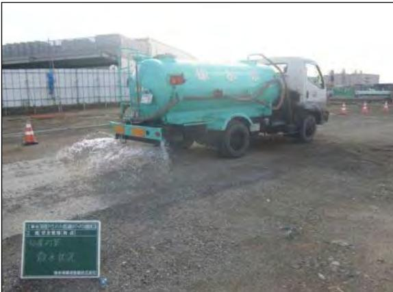
写真①-1 施工ヤードへの散水
