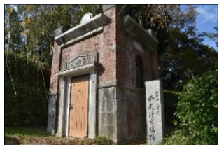
福岡市植物園に残る平尾浄水場跡
