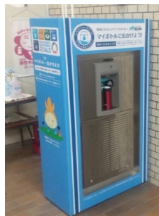
▲給水スポット (区役所等に設置)
