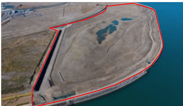
造成後の公園（平成31年3月）
