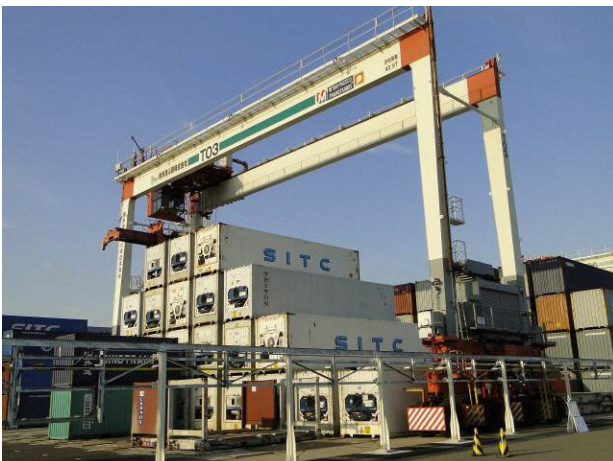
■電動トランスファークレーン
