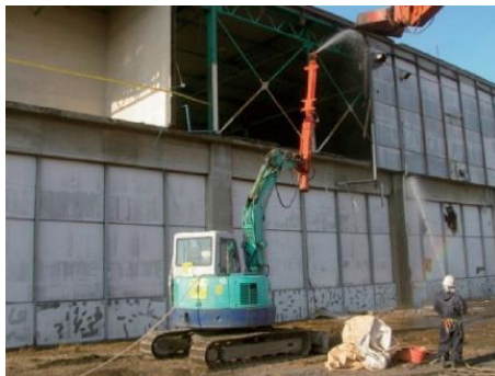
湿潤化の例(散水)
