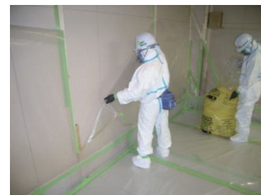
養生シートの撤去
