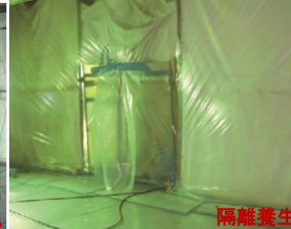
隔離＋集じん・排気装置を使用する方法
