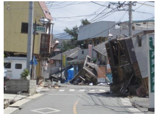
地震で損壊した建物
