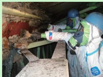
吹付け石綿の除去作業の様子
