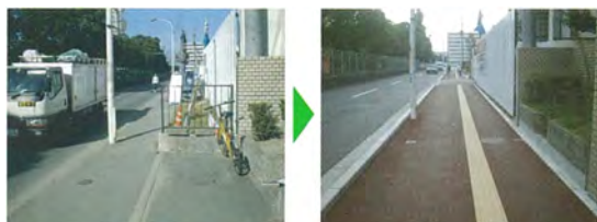
■歩道の整備 (歩道拡幅、誘導ブロックの設置)
