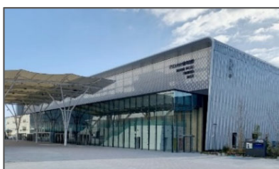
マリンメッセ福岡B館（令和3年4月供用）
