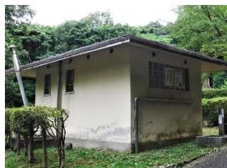
築45年が経過したトイレ
