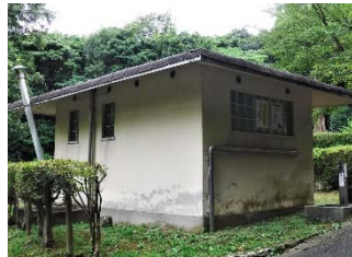
築45年が経過したトイレ
