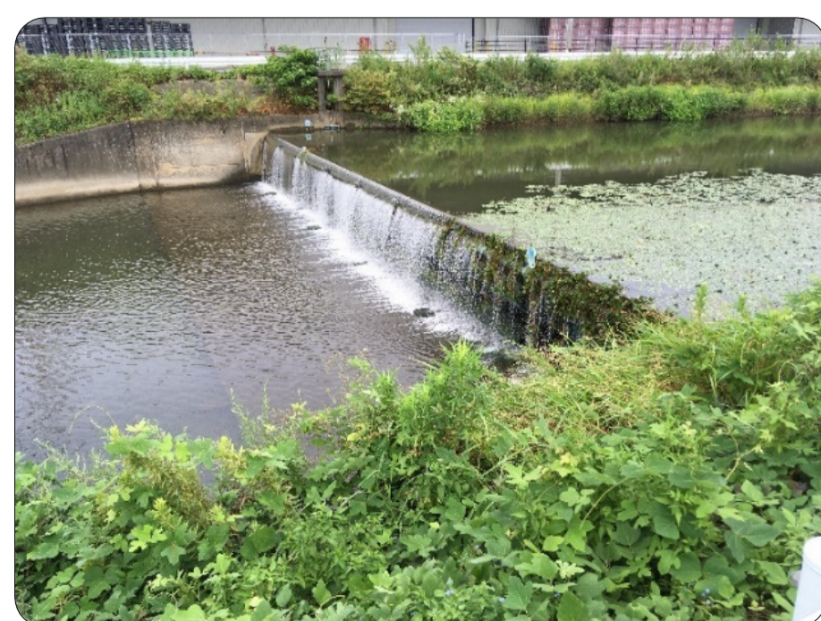
堰の倒伏は圧巻!
