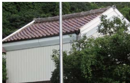
赤瓦の多い早良区の地域 例) 東入部・早良
