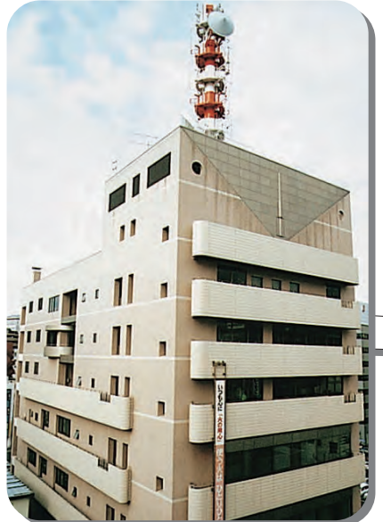
▲災害救急指令センターがある消防本部 (中央区)
