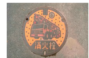
地中にうめられている消火栓
