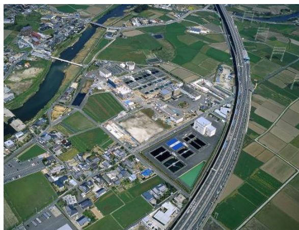
多々良浄水場
