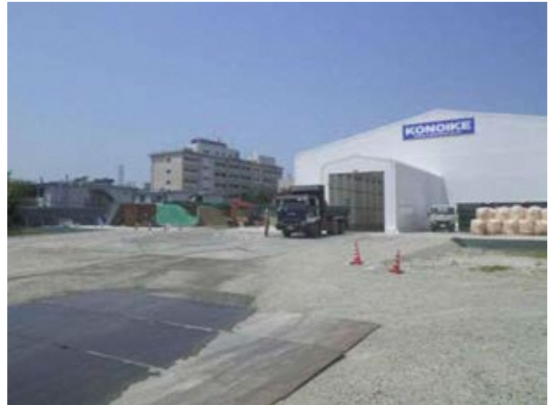
図 2.2-16 仮設洗浄処理プラント
