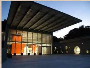
福岡市動物園エントランス 電気設備工事
