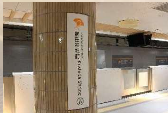
市営地下鉄櫛田神社前駅 電気設備工事
