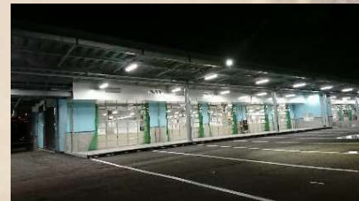
福岡市長浜鮮魚市場 卸売棟電気設備工事
