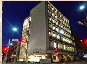
福岡市舞鶴庁舎 電気設備工事
