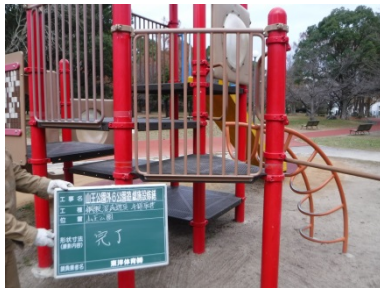
手すりの取替え
